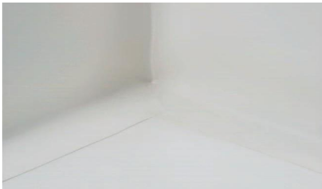
VAEPLAN® -Innenecke (90°) einschweißen
