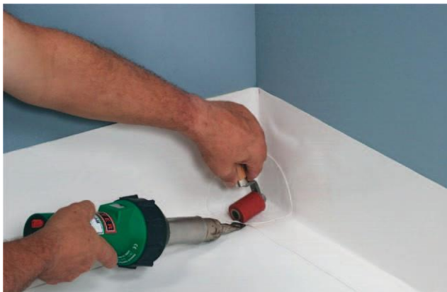
VAEPLAN® -Innenecke (90°) einschweißen
