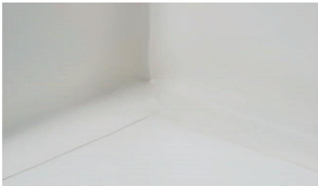
VAEPLAN® -Innenecke (90°) einschweißen
